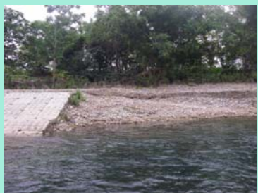
拡大した河岸先掘の様子
