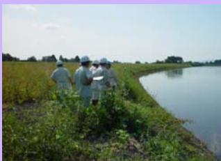
角間川護岸調査の様子
