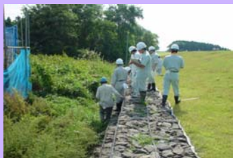
大仙地区築堤調査の様子
