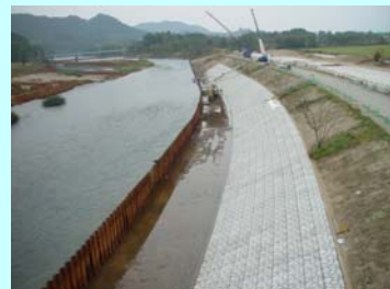
《護岸工事の様子 10月23日》
