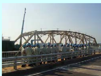
玉川橋旧橋撤去工事
