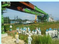
大浦跨線橋上部工工事
