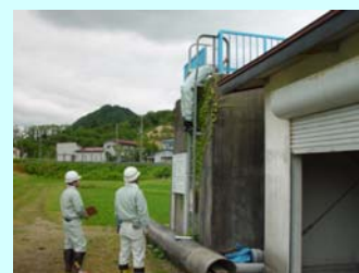
↑ 木直用水樋管 点検の様子
