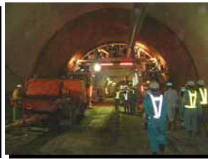
出戸トンネル内部
