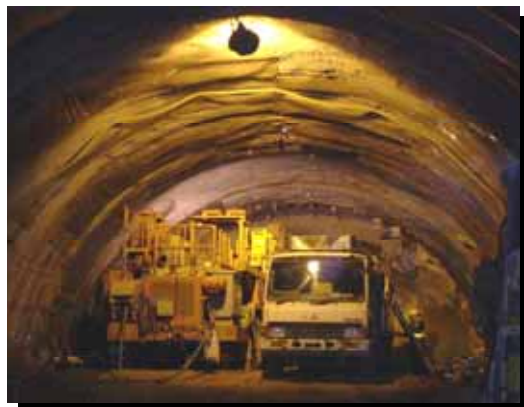
西目トンネル内部
