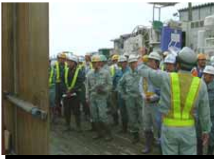
鈴木建設監督官の説明を聞く参加者（出戸トンネル）
