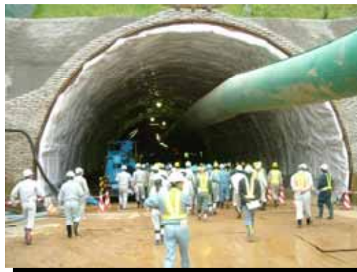
西目トンネル坑口（本荘側）
