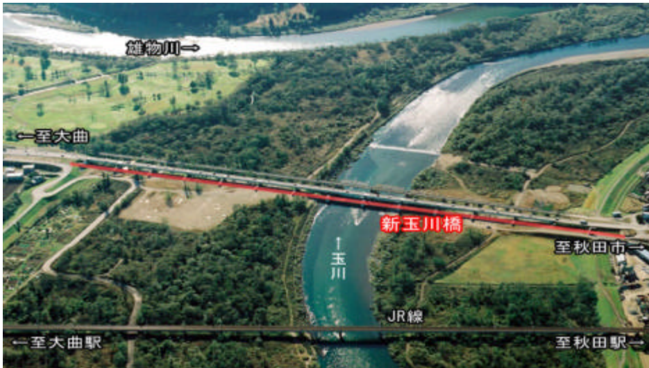
上空より架橋地点を望む
