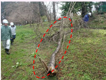
遊歩道上に、大きな木の枝が倒れている状況を確認
