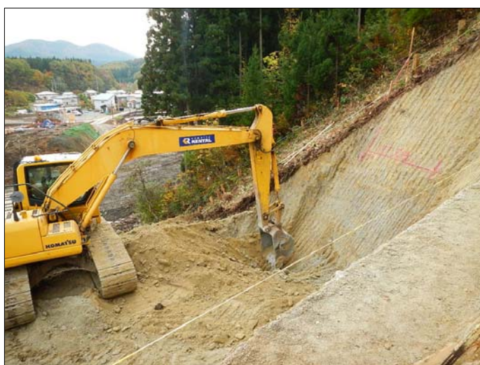
砂防本体工事、堰堤部(右岸)の掘削作業状況
