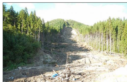
工事着手前(9月27日撮影)
