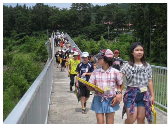
生保内川遊砂地(大暗渠砂防堰堤天端を探検中!)
