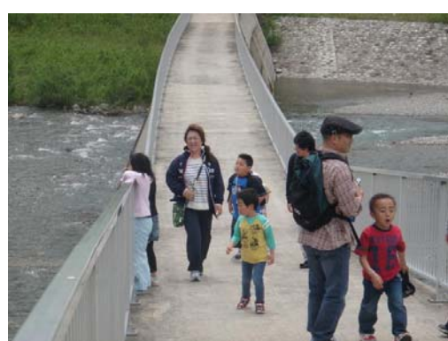
○大暗渠堰堤天端
