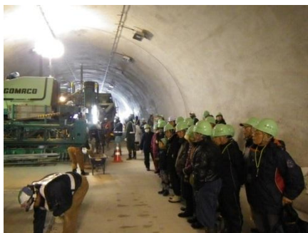
1時間後の普通コンクリートと超早強コンクリートの固まり具合を検証
