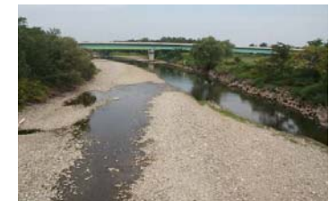
皆瀬川岩崎橋地点の状況(横手市・湯沢市)
