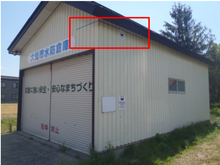
大仙市水防倉庫
