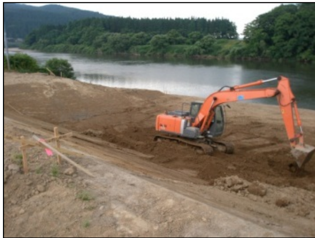
河道掘削状況(秋田市新波地区)
