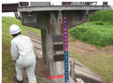
樋門樋管点検状況
