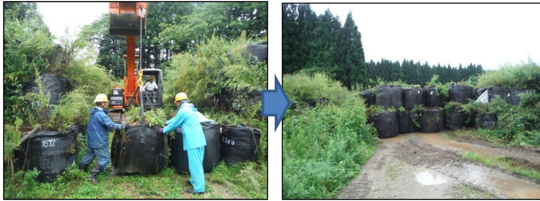
大仙市間倉地区において、大型土のうを設置し、浸水被害の未然防止対策を行った。(延長 約50m)
