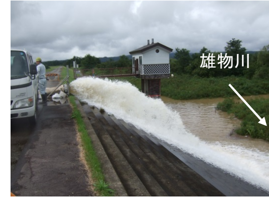
角間川排水状況
