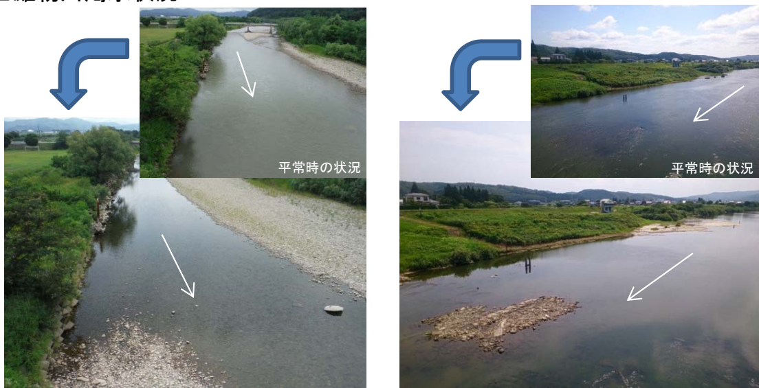
皆瀬川新岩崎橋地点(H27.8.10)
