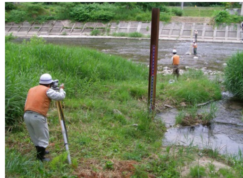
定期横断測量の状況
