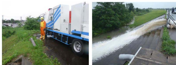
排水ポンプ車による排水活動
