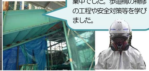
窪田横断歩道橋では、防護服を着用しての塗装剥離作業中でした。歩道橋の補修の工程や安全対策等を学びました。
