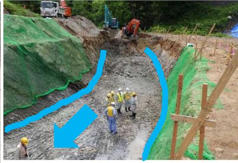
川の増水によって道路が削り取られたので、川の位置を変える工事をしています
