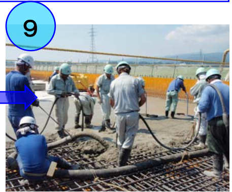
9 様々な道具を使ってコンクリートを流し込んだり、均したりします。
