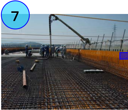
7 地上からコンクリートが送られてきます。
