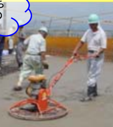
■トロウエル 床面に打設したコンクリートをならすために用いられる機械です。機械にコテが付いていて、回転させながらコンクリートを平らにします。
