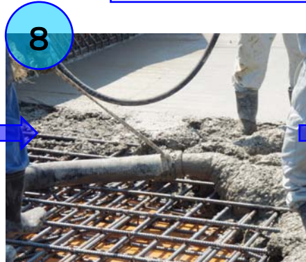
8 筒状の管を通してコンクリートが運ばれます。
