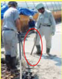
■高周波バイブレーター コンクリートが隅々まで行き渡るように振動を与える道具です。
