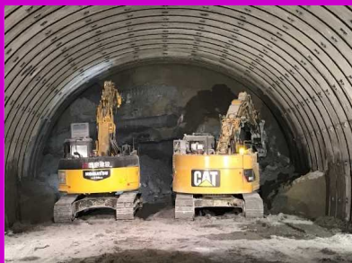
岩清水トンネル工事 鹿島建設(株)
