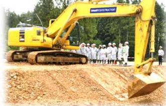
油圧ショベルによる法面整形の様子
