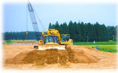
ブルドーザーによる敷均しの様子
