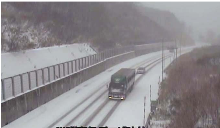
9日の月山道路(西川町志津地内)の路面状況です。 夏タイヤでの走行は非常に危険です！ また、山形県道路交通規則にも違反します。
