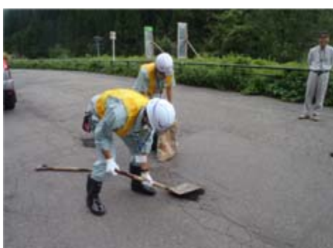
常温合材で穴を埋めて応急処置をします
