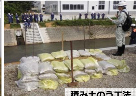
積み土のう工法
