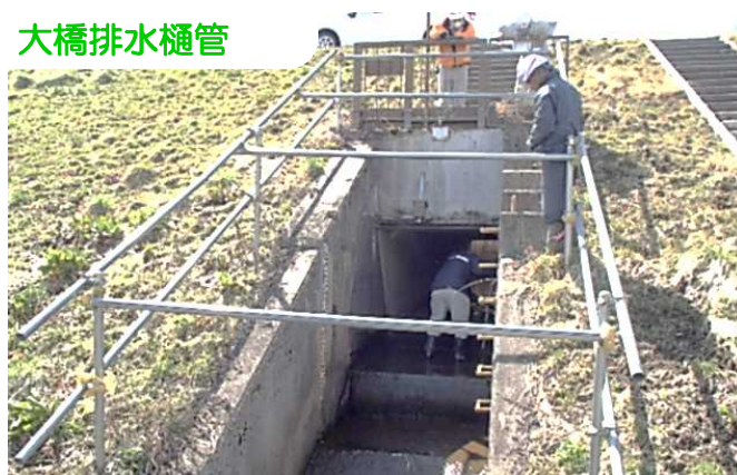
▲ 水路の清掃・点検
