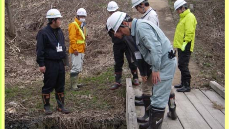
異常なし(点検の様子)
