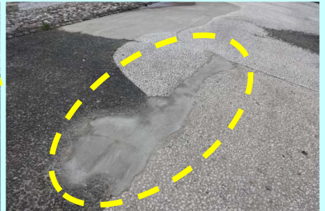
→ 補修完了(4月17日)
