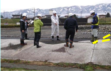
＜噴水周辺のモルタルの破損＞
