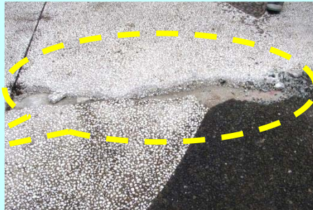
＜噴水周辺のモルタルの破損＞
