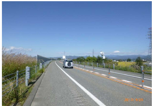
東北中央自動車道(ネクスコ区間)における中分ワイヤロープ設置状況
