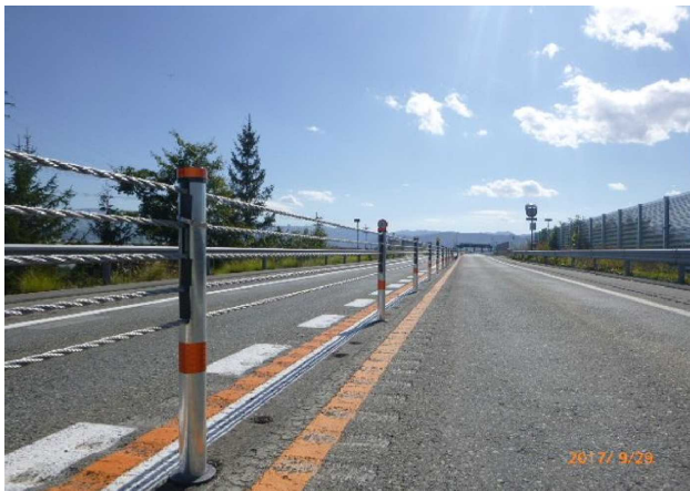
東北中央自動車道(ネクスコ区間)における中分ワイヤロープ設置状況
