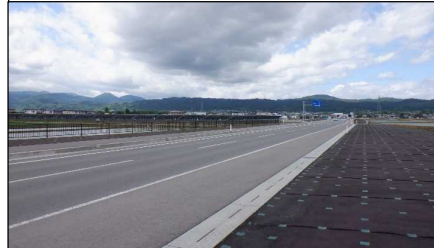
県道 山形山辺線BP 付近
