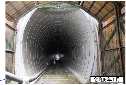
陸羽西線 第二高屋トンネル(完了後)
