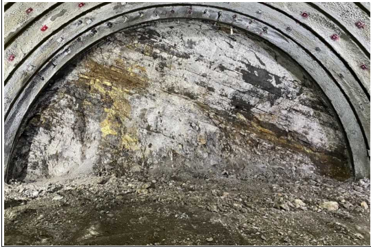
高屋トンネル(切羽写真)
