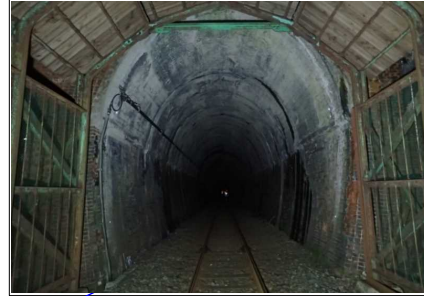
陸羽西線 第二高屋トンネル(着手前)
