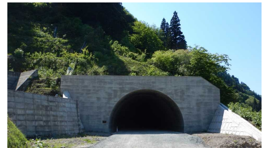
猪ノ鼻トンネル(新庄側)
