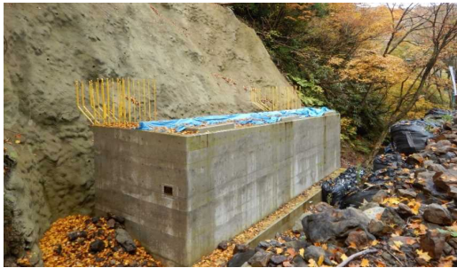
有田沢橋酒田側橋台
