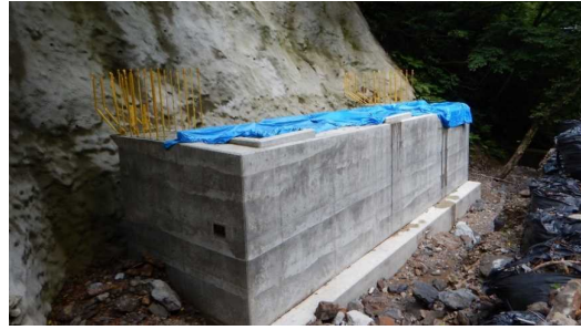
有田沢橋酒田側橋台
