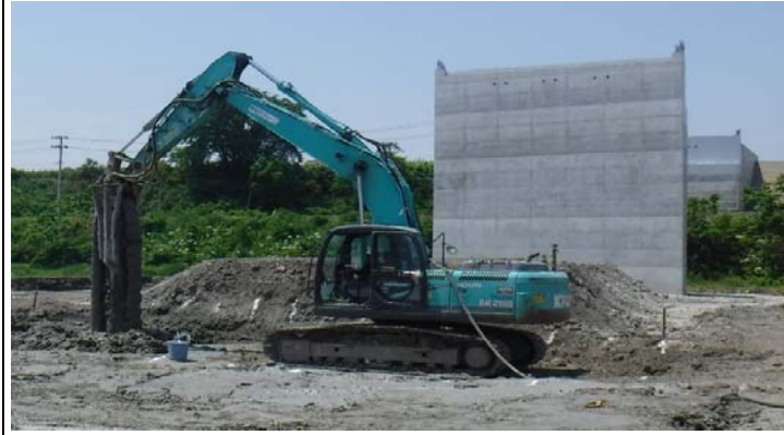
津谷跨線橋付近(酒田方面)
