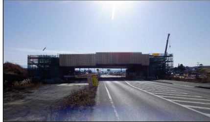
川西IC橋 付近
