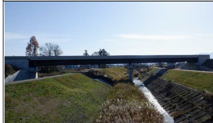
元宿川橋 付近
