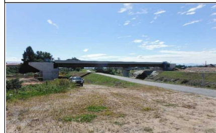
元宿川橋 付近
