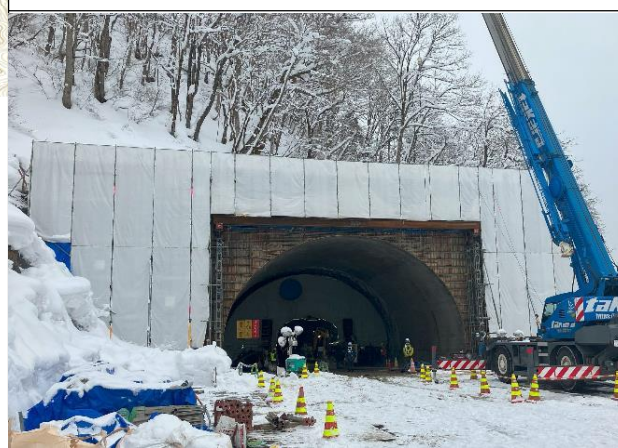
新及位トンネル(終点側抗門工)
