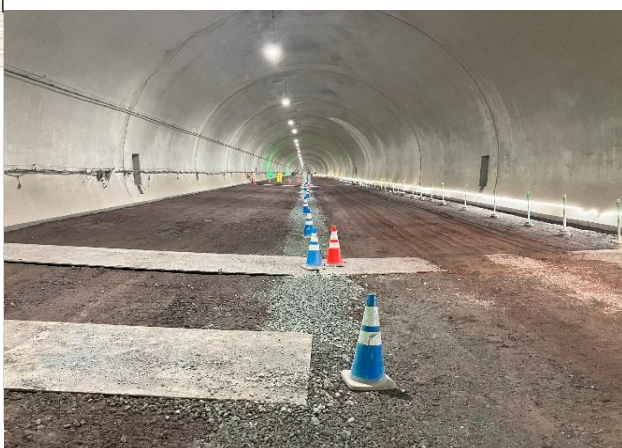
新及位トンネル(坑内 中央排水工)
