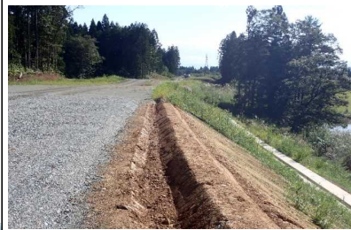
十日町西山中地区(尾花沢方向)
