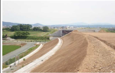
泉田川橋(尾花沢方向)
