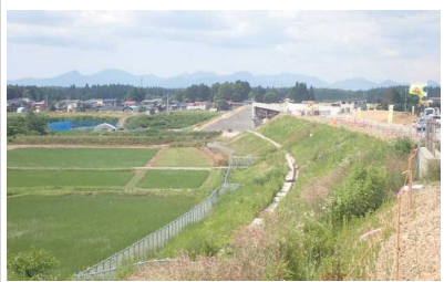
泉田川橋付近(金山方向)
