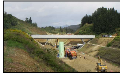
村山跨道橋(新庄方向)
