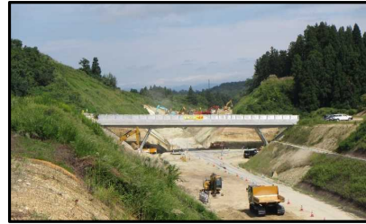
村山跨道橋(新庄方向)
