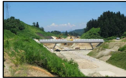
村山跨道橋(新庄方向)
