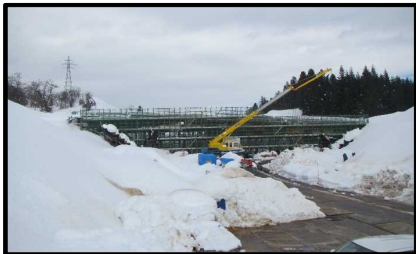
村山跨道橋(新庄方向)
