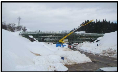
村山跨道橋(新庄方向)
