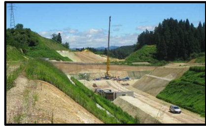
村山跨道橋(新庄方面)
