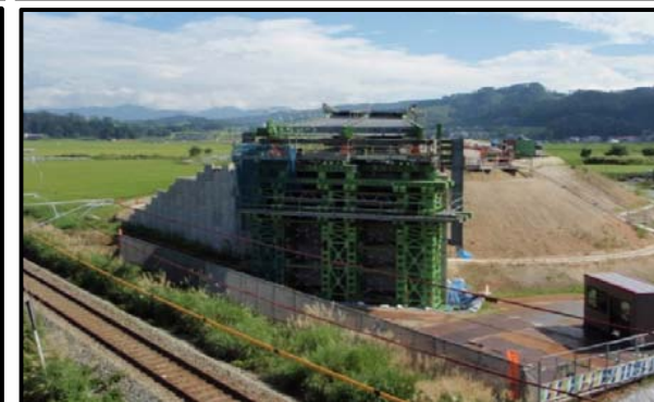
袖崎こ道橋(新庄方面)
