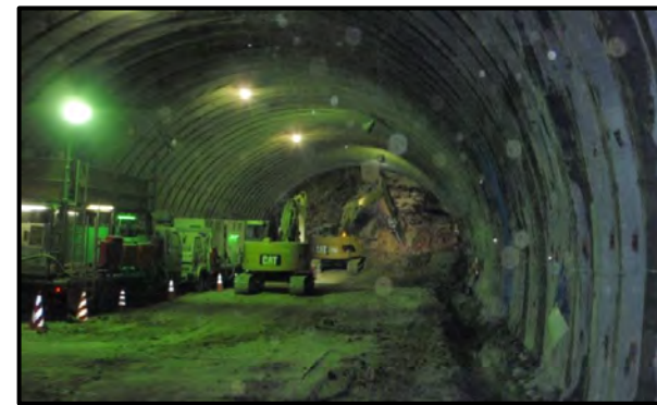
村山トンネル
