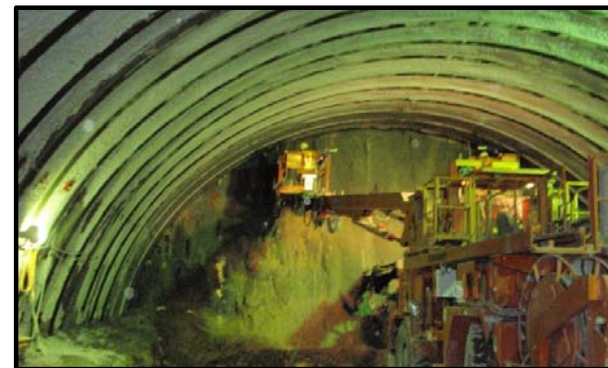
村山トンネル
