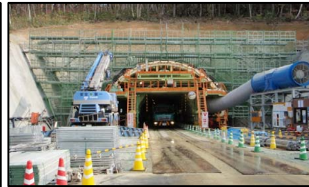
村山トンネル
