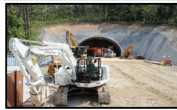
村山トンネル
