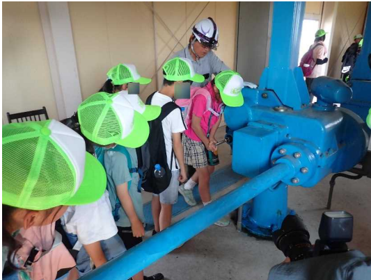
樋門操作体験
