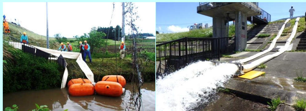
【ポンプの設置】
