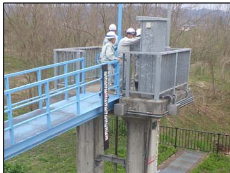
【寒河江出張所管内】 施設点検状況(船町排水樋管)
