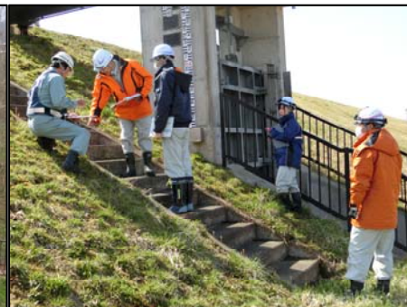
【長井出張所管内】 施設点検状況(荒砥第7排水樋管)
