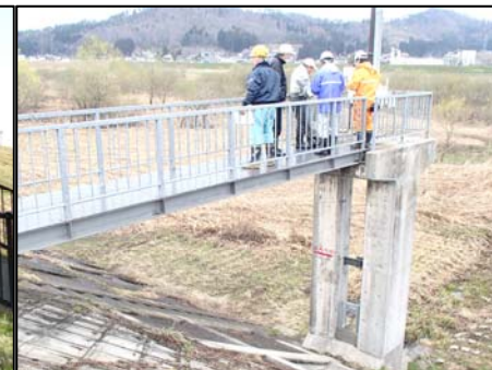
【南陽出張所管内】 操作方法再確認(羽山第2樋管)
