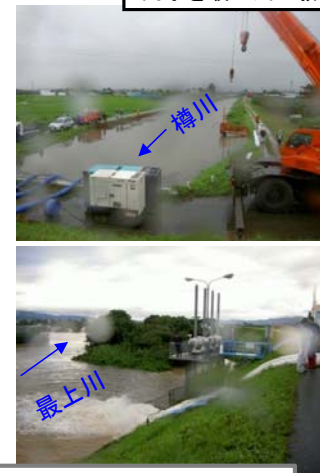
蔵増地区排水作業状況 内水を最上川へ排水
