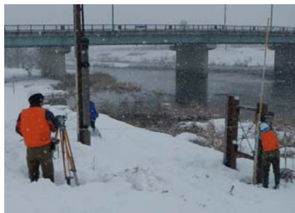
定期横断測量の状況
