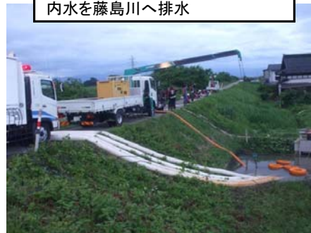
押切新田地区排水作業状況 内水を藤島川へ排水
