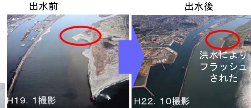
斜め写真による河道状況の把握 (平成19年9月洪水による河口砂州形状の変化の様子)
