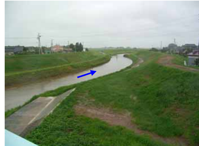
京田橋下流の築堤及び河道掘削状況
