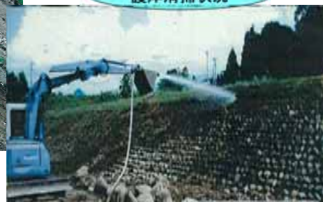
護岸清掃状況
