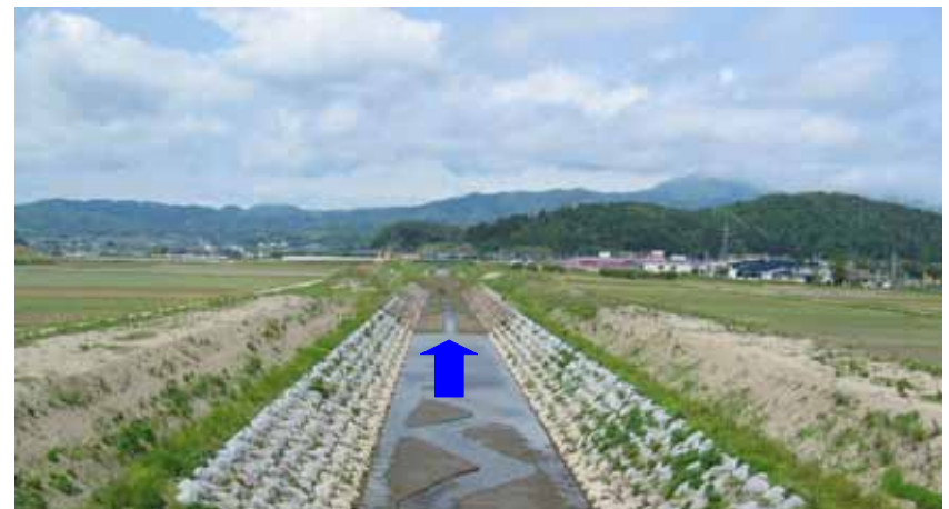
大旦川支線大沢川の流下能力向上の築堤及び河道掘削状況
