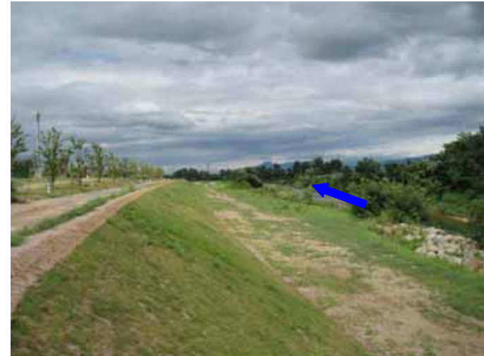
門伝橋下流左岸の築堤状況(山形市西公園付近)
