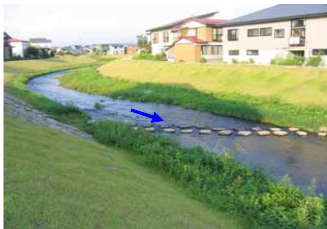
桧橋下流の河道掘削状況
