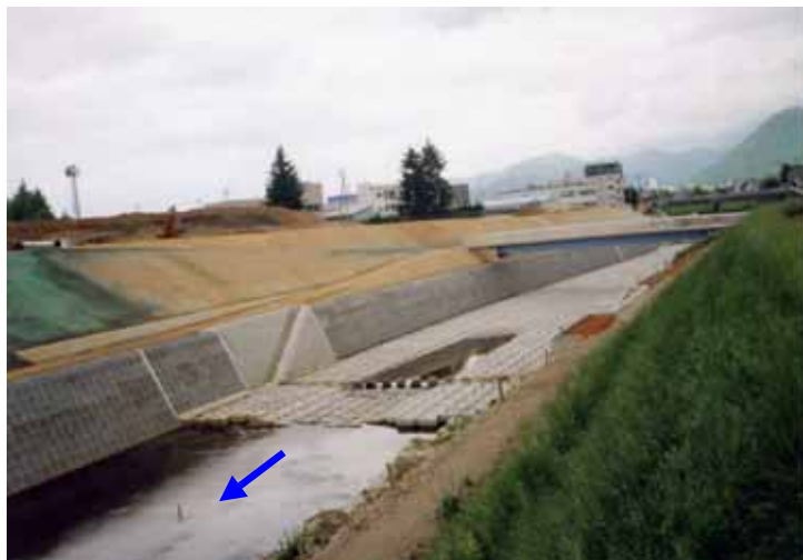
JR橋梁上流部の狭窄部解消状況
